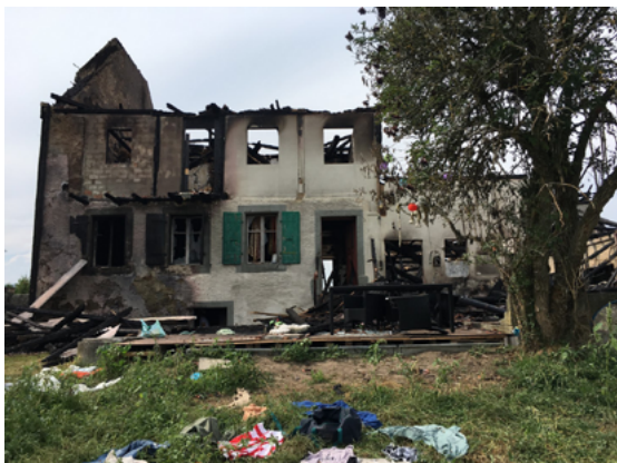
Incendie du 2 août 2018 à Fétigny
